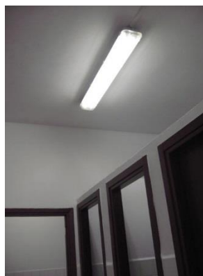
Figura 4.14 - Particolare dei corpi illuminanti a fluorescenza tipo T8 2x36W ubicati nei servizi igienici
