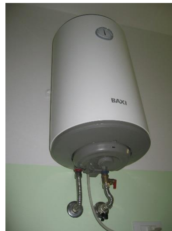
Figura 4.12 - Particolare di un boiler elettrico per la produzione di ACS
