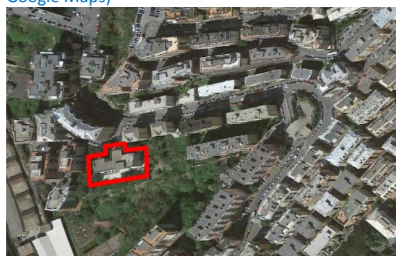
Figura 2.2 - Vista satellitare dell'edificio (Fonte: Google Maps)
