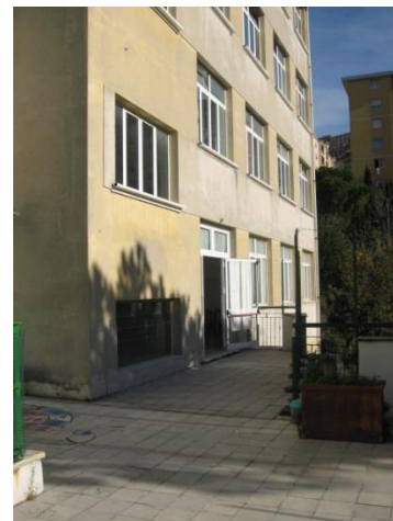
Figura 4.2 - Particolare della facciata Sud e della copertura Palestra Sud
