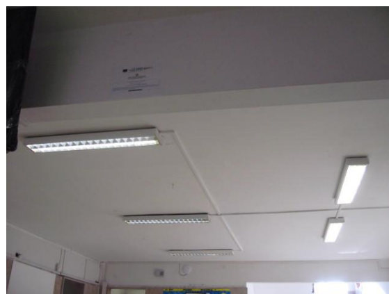
Figura 4.13 - Particolare dei corpi illuminanti a fluorescenza tipo T8 2x36W ubicati nei corridoi
