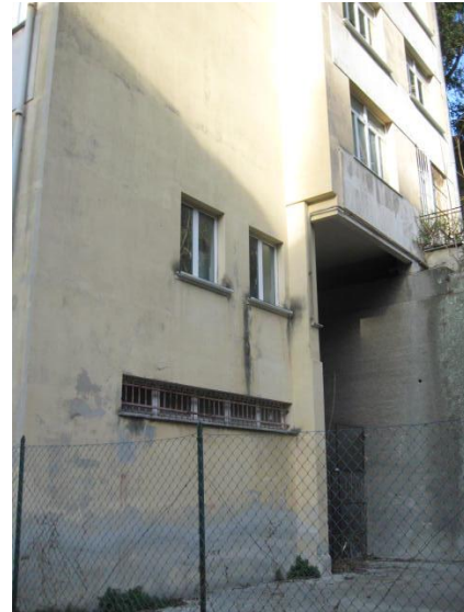
Figura 4.1 - Particolare della porzione di involucro; in evidenza i piani sfalsati e l'intercapedine
